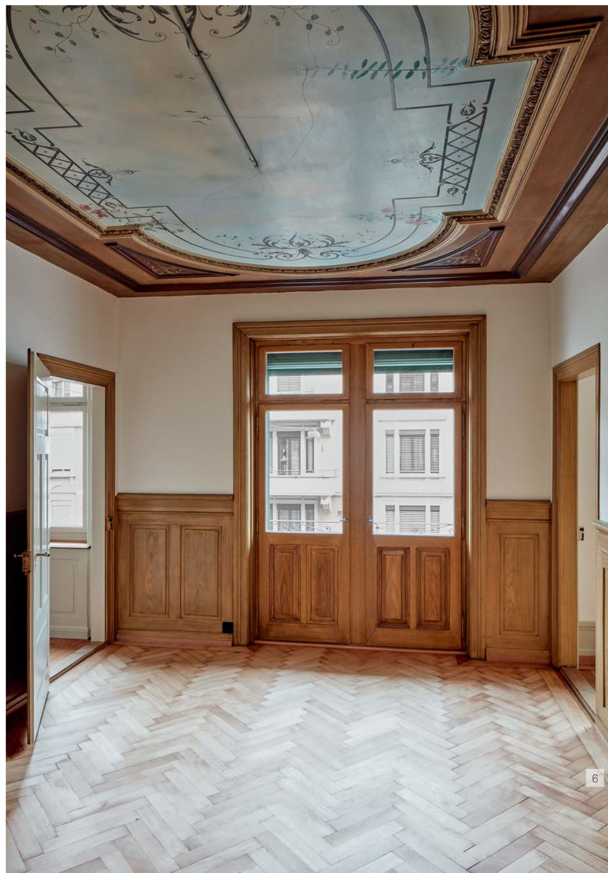
6 Neue Fenster tragen zur optimierten Gebäudedichte bei und lassen dank schlanker Profile viel Tageslicht in die Räume.
